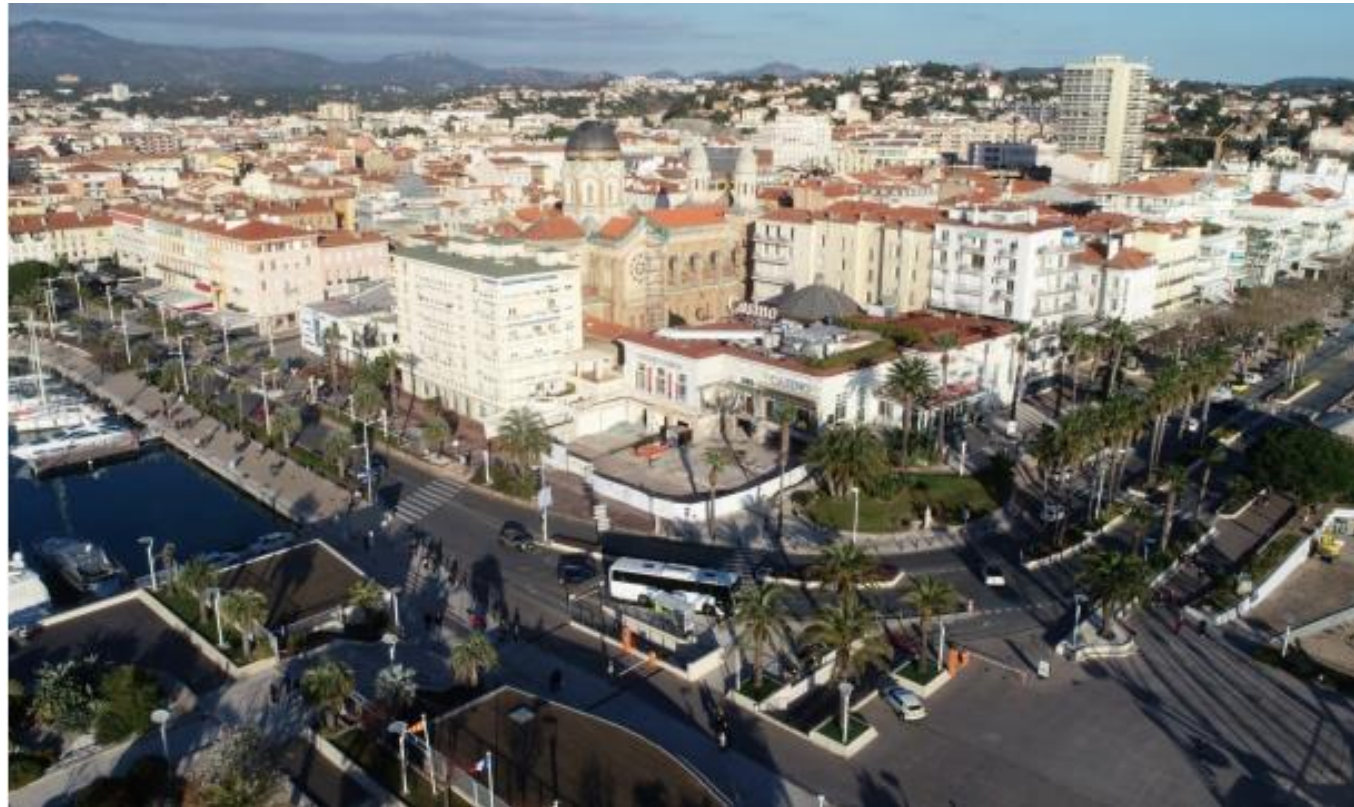
Vue générale Casino Barrière– état existant
